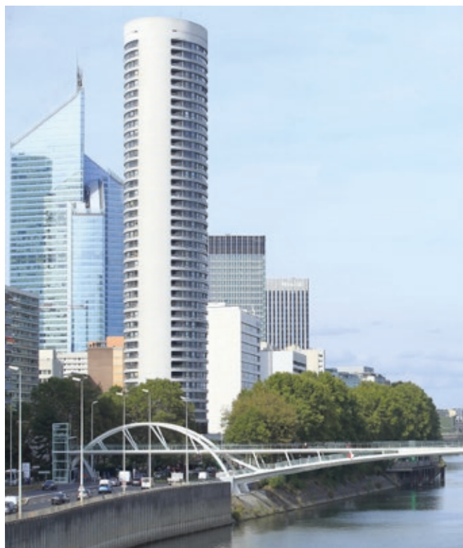
La passerelle Coty à Puteaux
